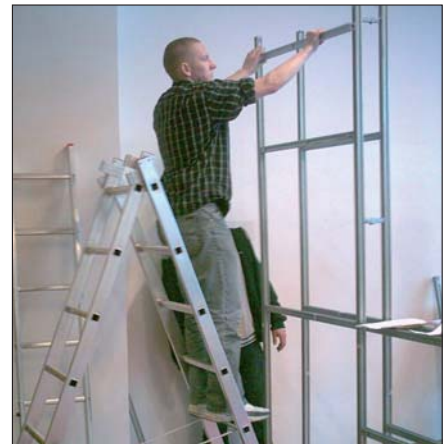
Aufbau der Vorwandinstallation und Hebeanlage beim Kunden.
